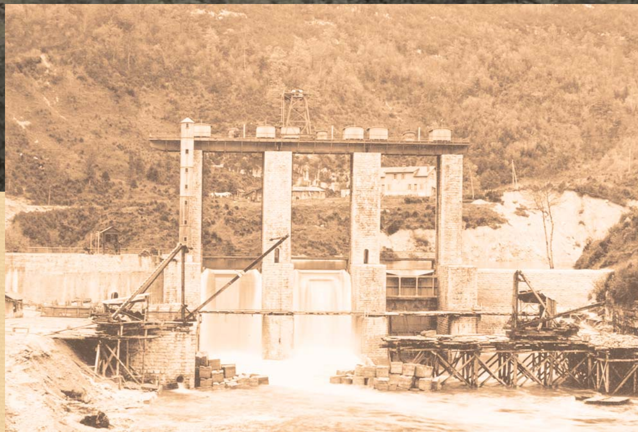
1912. Antico sbarramento in fase di costruzione
